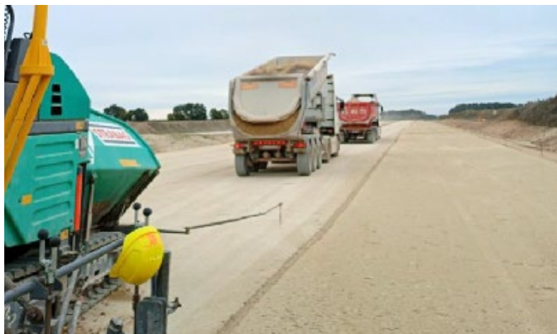
Fot. praca rozściełacza na realizowanej budowie S19 Boćki - Malewice.
