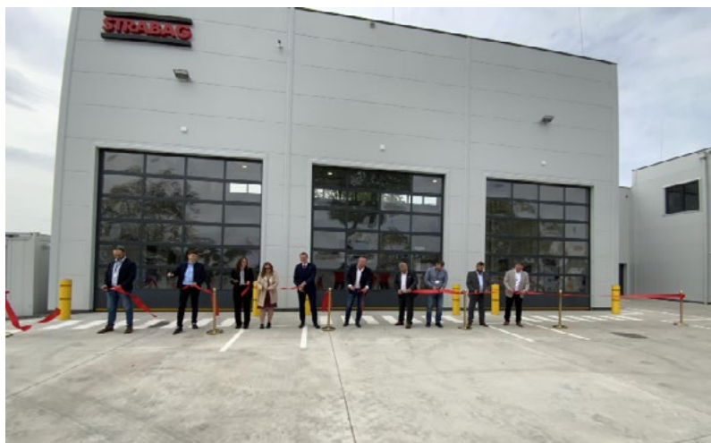
Fot. Nowa siedziba STRABAG BMTI w trakcie budowy oraz podczas uroczystego otwarcia w dn. 14 maja 2025 r.
