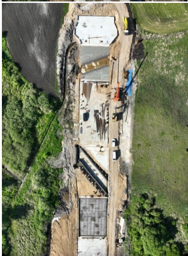
Fot. (górze) betonowanie 7 płyty zespalającej pale na dojazdach, (górze) Roboty żelbetowe na płycie zespalającej pale sekcje 16-20.
