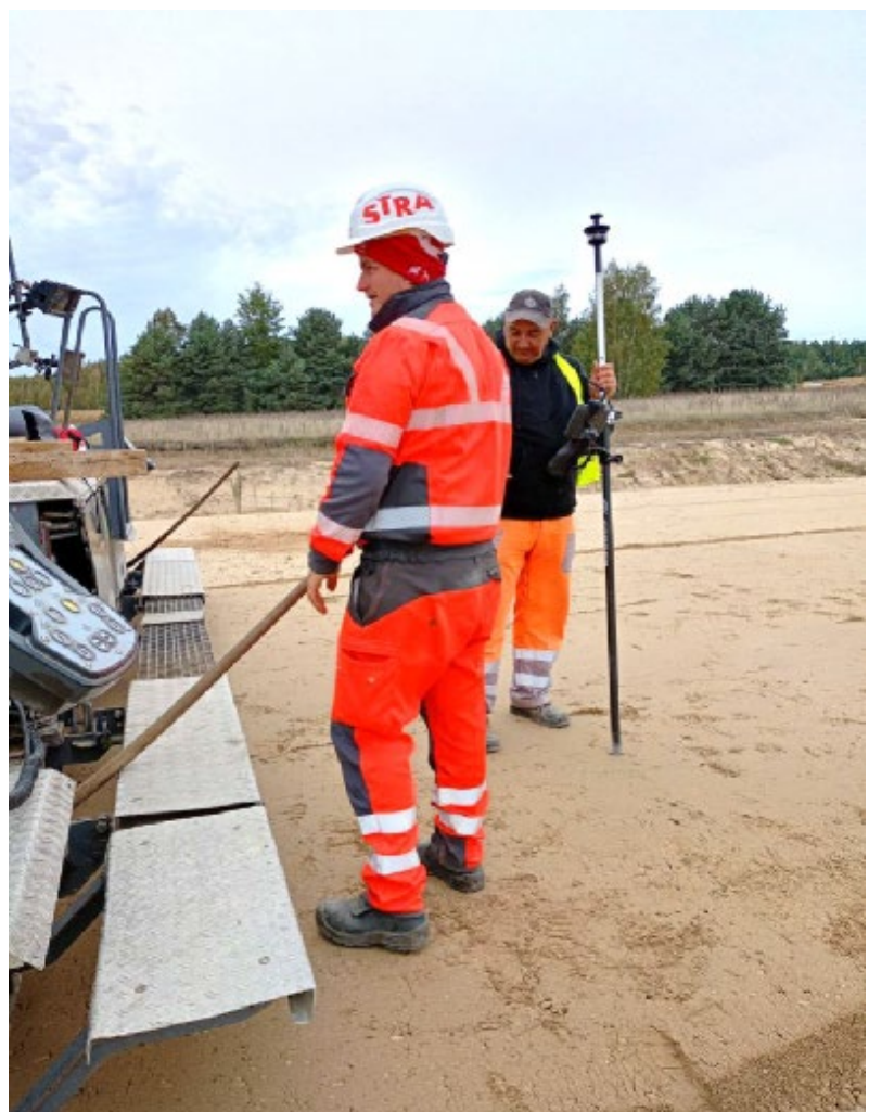
Fot. Pracę rozściefacza wspierają digitalne narzędzia pomiarowe tyczki pomiarowe.
