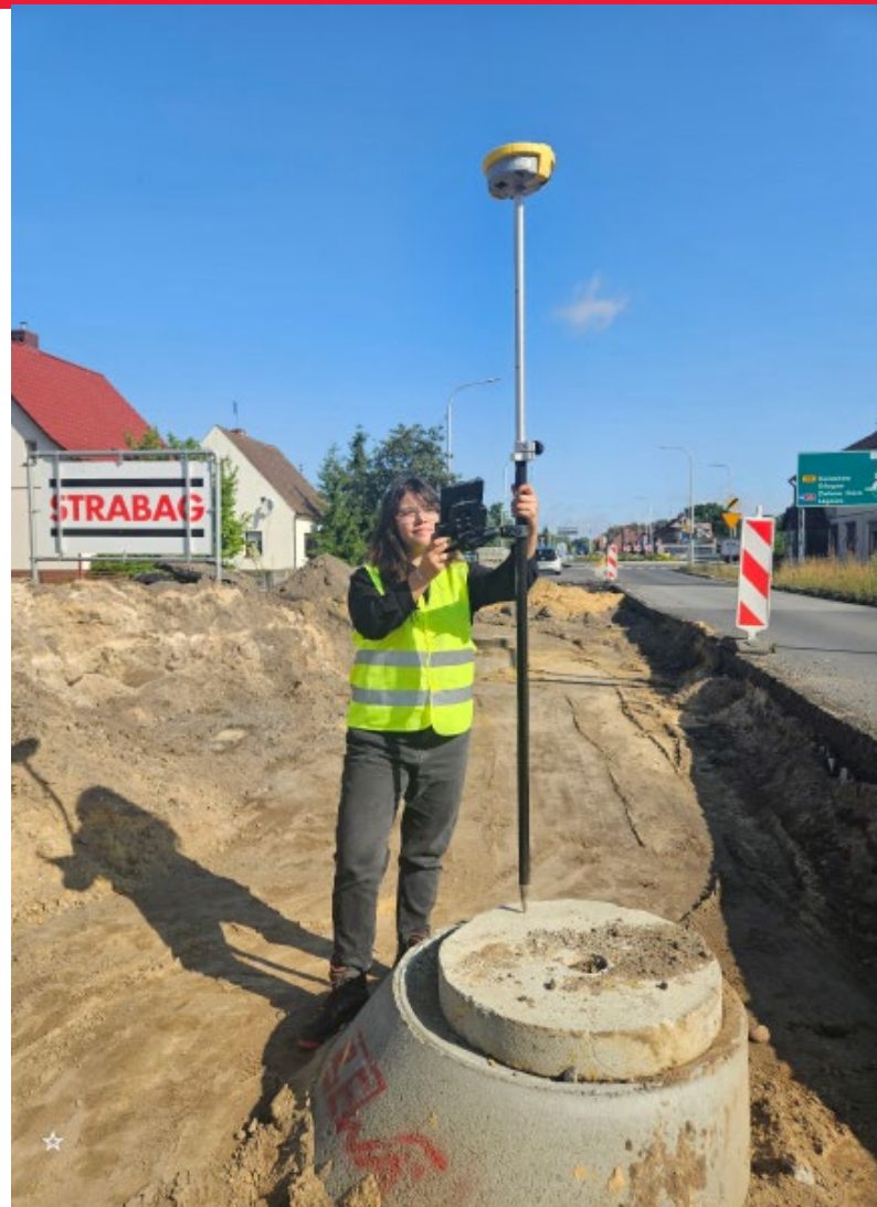
Fot. Pomiary wykonywane przy pomocy tyczki GeoMax.
