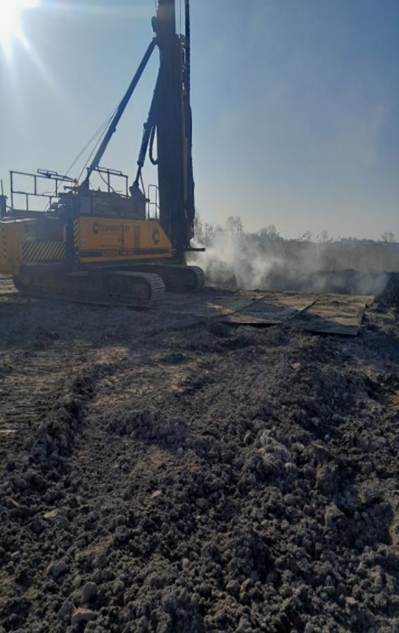
Fot. (po lewej) Praca kafara przy wbijaniu pali pod konstrukcję estakady.
