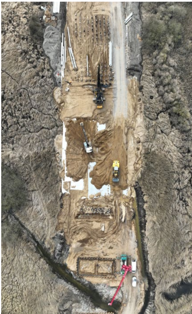
Fot. Trudne warunki gruntowe, w których prowadzone są prace przy estakadzie.
